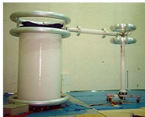
带有阻尼电阻的 350kV, 2A 的测试系统
