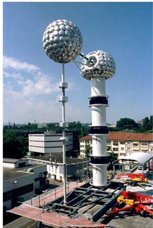
由四个变压器级联而成的 1,500kV, 1.2A 测试系统
