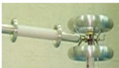
300kV系统上典型的阻尼电阻安装图
